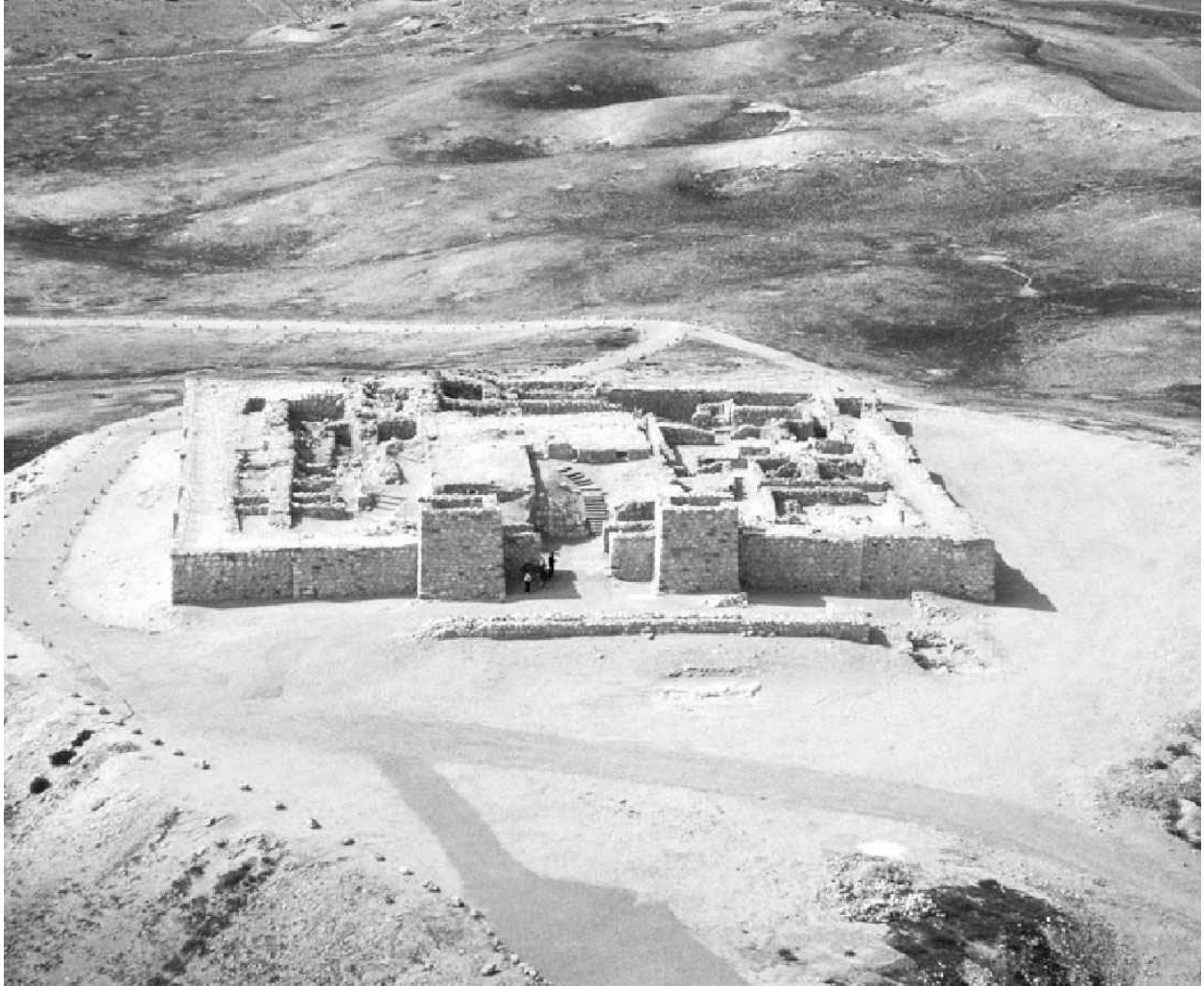
Excavaciones en el tell Arad
