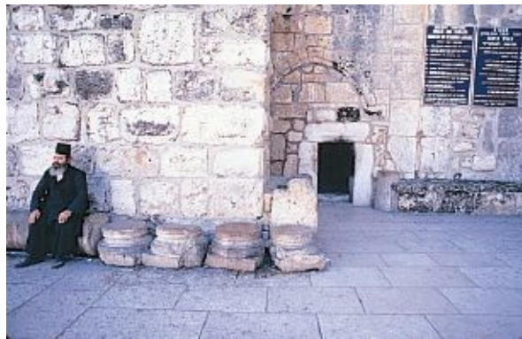
Pequeña entrada a la Iglesia de la Natividad, en Belén. Se cerró y rellenó el arco de entrada para evitar el ingreso de hombres a caballo.
