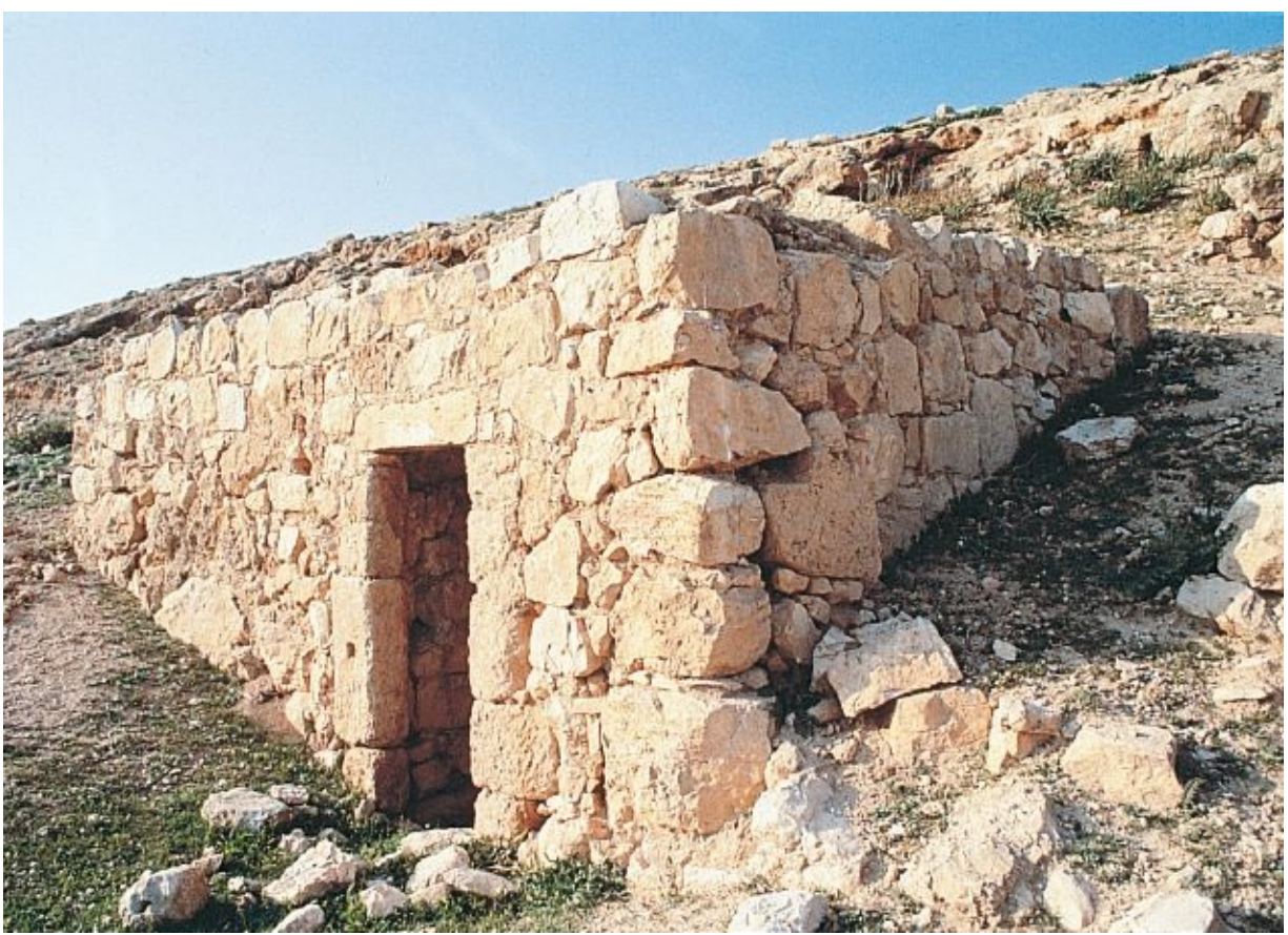
Ruinas de un pequeño edificio que probablemente data de los tiempos posbíblicos en Tecoá, Israel, el lugar originario de Amós.
