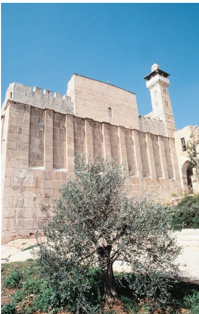
Estructura herodiana construida sobre la cueva de Macpela, el lugar donde Abraham sepultó a Sara.
