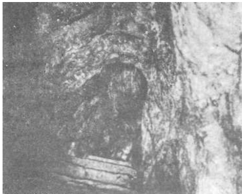
Entrada del túnel del Siloé. (© MPS)
